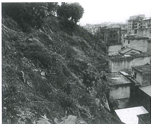
丰顺金瓯山施工前
