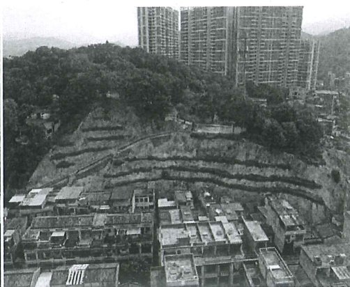
丰顺金瓯山施工后
